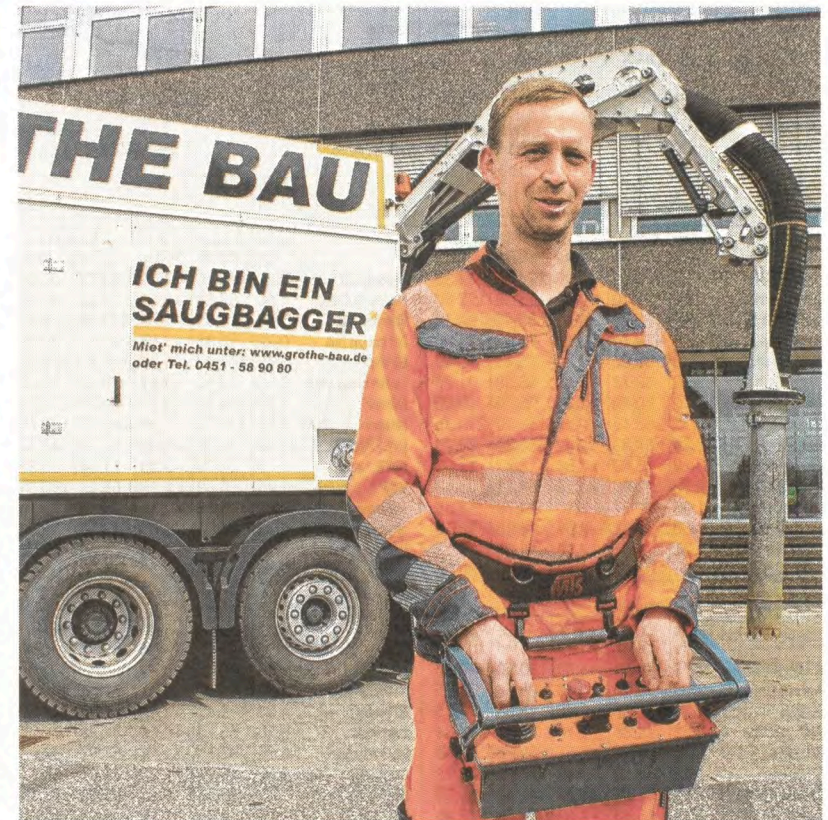
Michael Vohs bedient die neueste Errungenschaft der Firma Grothe. Ein Saugbagger macht den Tiefbau deutlich effizienter.
