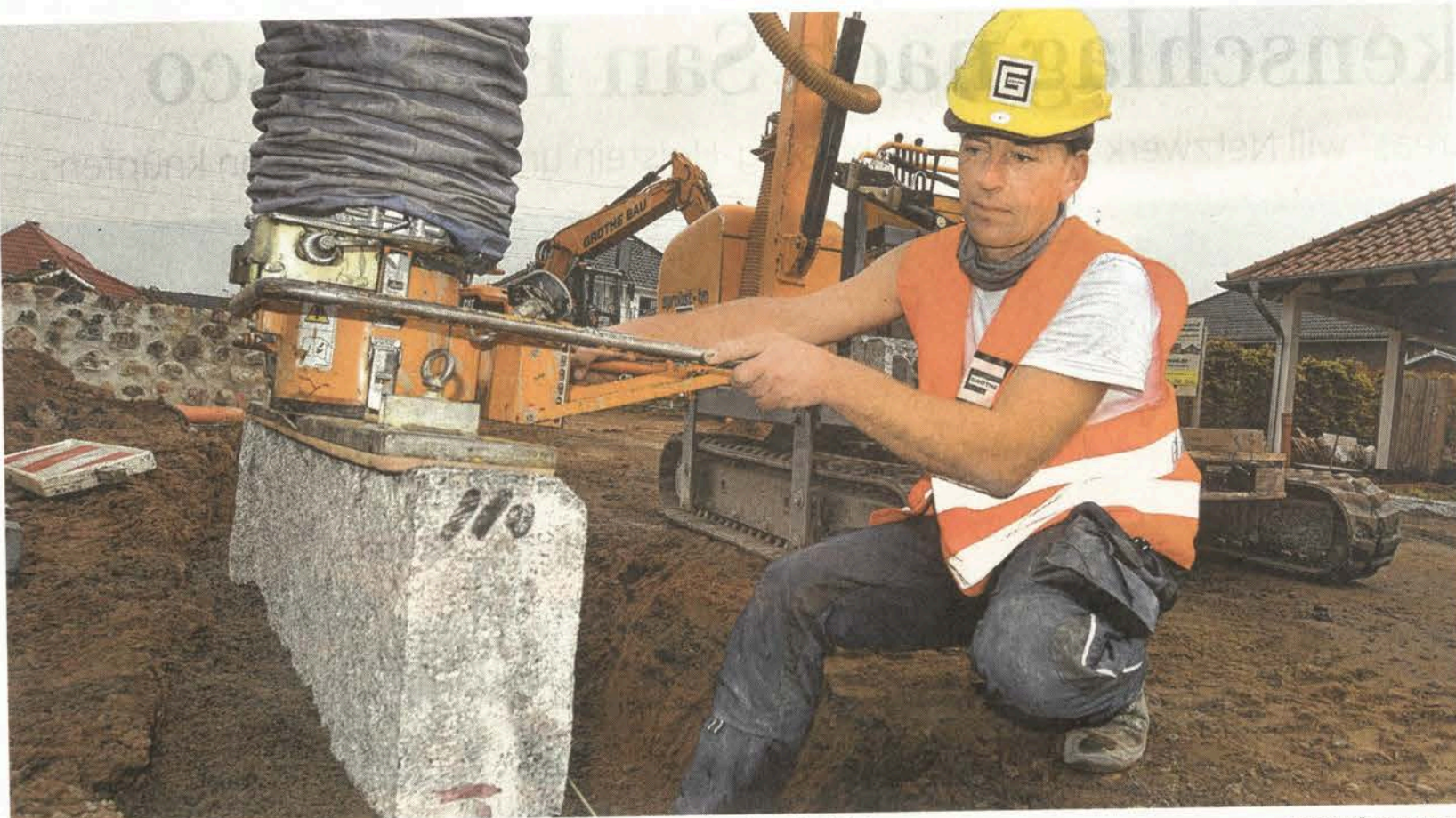
Maschinenkraft statt Muskelspiel: Straßenbauer Peter Griepentrog (42) setzt einen Bordstein.
